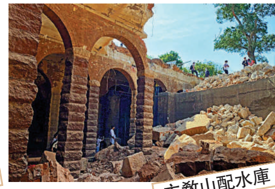
主教山配水庫
