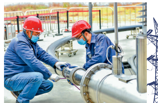
▲深圳供電局專家在做超導電纜安裝調試。
