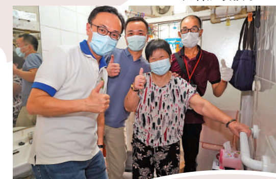
▼聶德權到訪觀塘翠屏邨，並變身「維修工」，為獨居長者加裝扶手。
