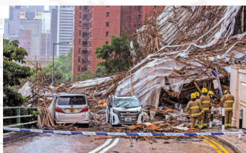
▲本月8日熱帶風暴「獅子山」襲港期間，跑馬地樂活道一棟大廈的外牆棚架疑受強風及天雨影響倒塌，壓倒經過的汽車。
