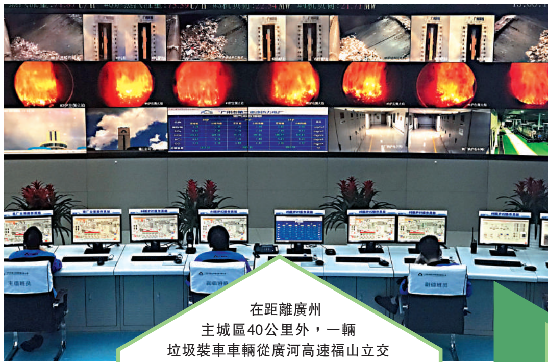
廣州第三資源熱力電廠的工作人員在監測焚燒爐。大公報記者敖敏輝攝
