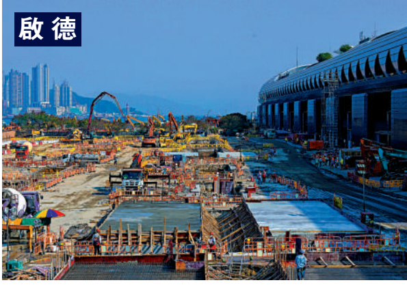
▲啟德方艙醫院佔地逾8萬平方米，建成後將提供逾3000個隔離單位。
