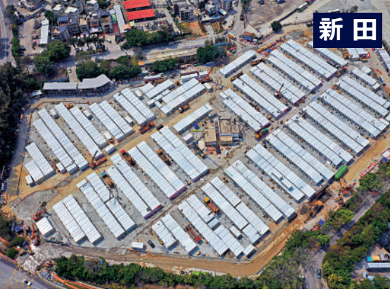
▲前新田購物城方艙醫院正在趕工中。
