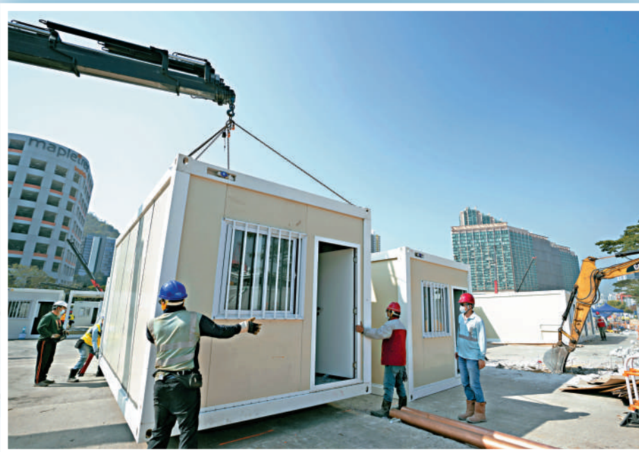
▲工作人員在青衣方艙醫院施工。
