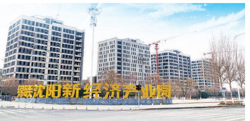
▲正在建設中的瀋陽新經濟產業園
