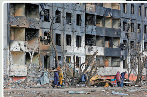
馬里烏波爾一棟公寓樓在襲擊中部分坍塌。路透社
