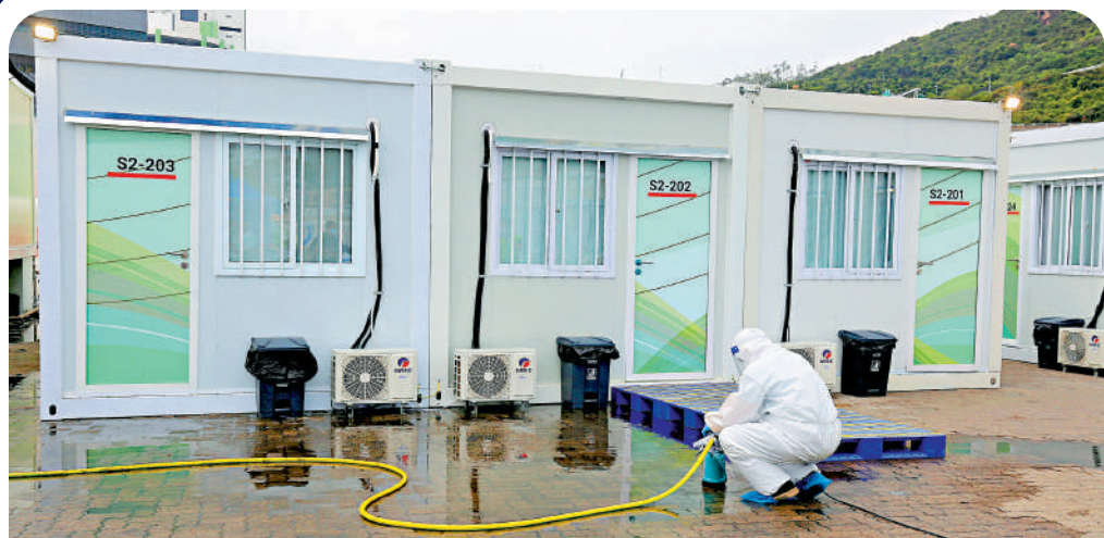
因應未來一周下雨可能水浸，維修人員預演使用水泵緊急清理，近日更已預先將低窪地區的積水抽走。 大公報記者黃洋港攝
