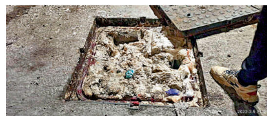
青衣方艙早前發生水浸事件，維修人員打開去水井後發現大量濕紙巾、口罩等物件造成淤塞。
