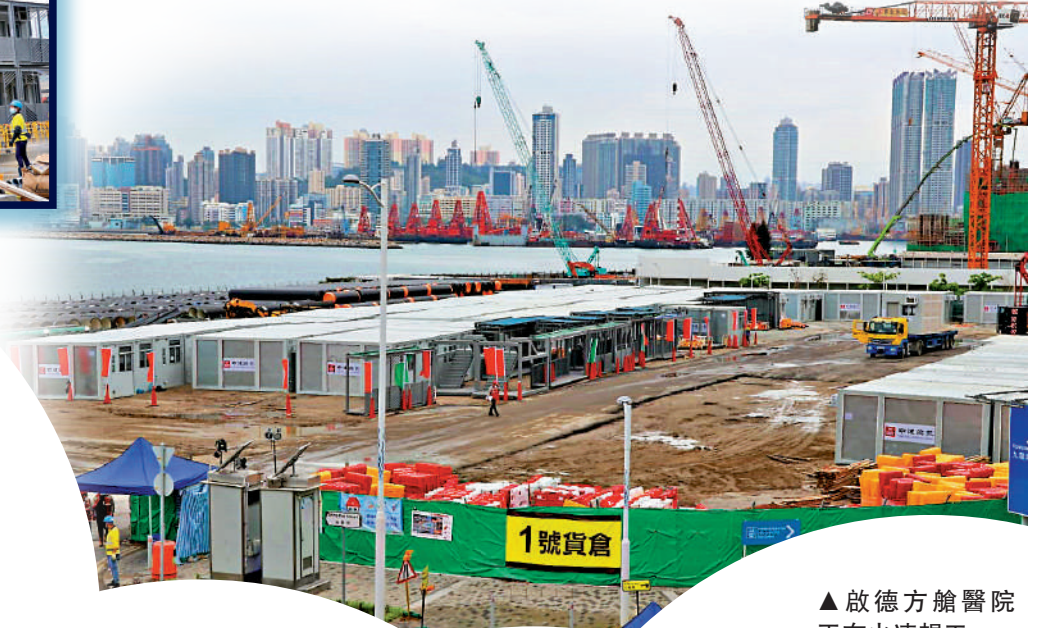
▲啟德方艙醫院正在火速趕工。
