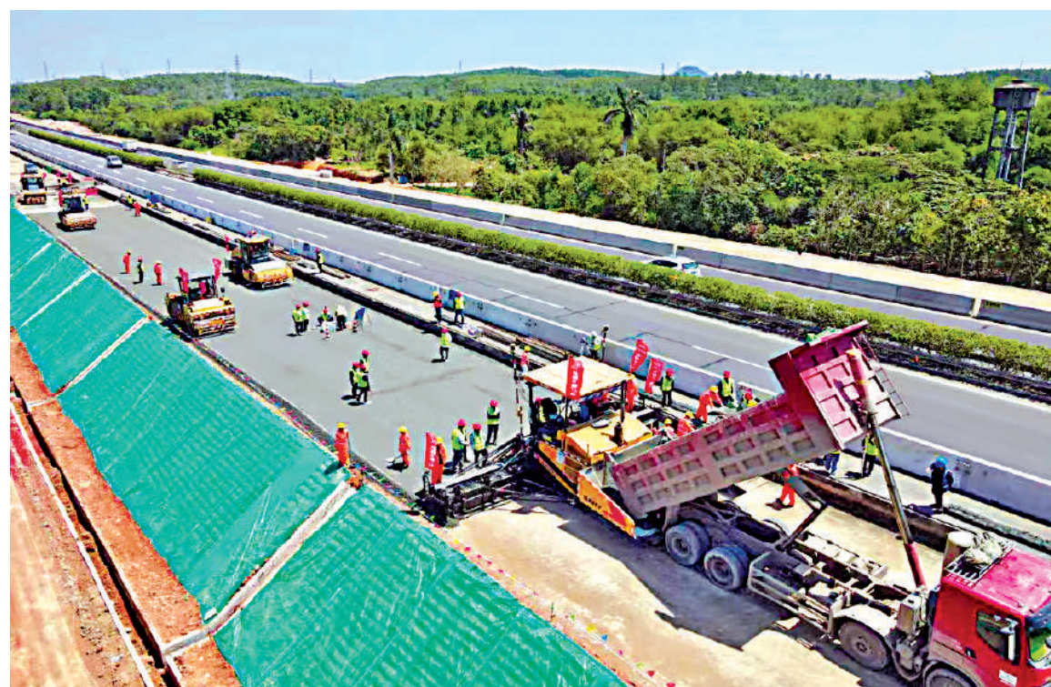
茂湛高速改擴建路面上3D「打印」，採用新型工藝3D路面攤鋪。受訪者供圖
