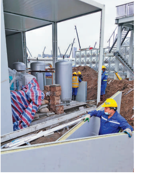
▲東方廣廈工人正在施工組裝打包式箱房。受訪者供圖
