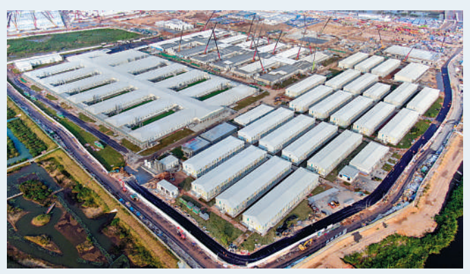
▲4月7日，位於香港落馬洲河套地區的中央援港應急醫院一期竣工交付。新華社
