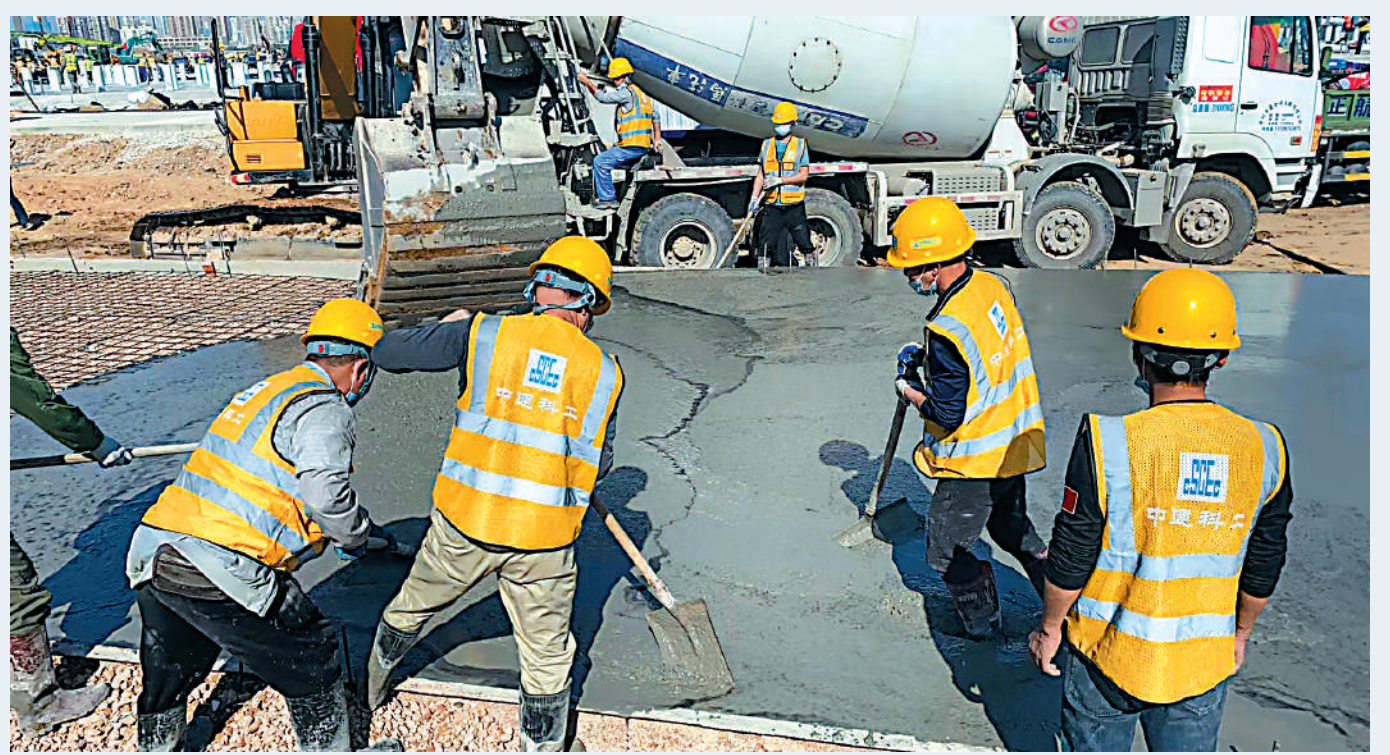
▲深圳匯基已向河套應急醫院項目供應各等級混凝土5萬立方。圖為工人正在作業。受訪者供圖
