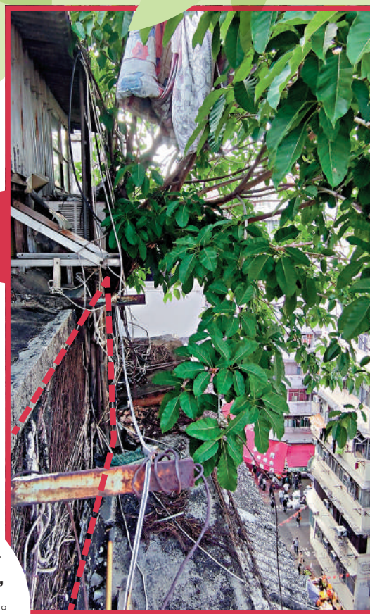
▶▶ 深水埗石屎剝落的唐樓，天台樹依附鐵皮屋外牆生長，樹根攀附外牆(紅框示)。
