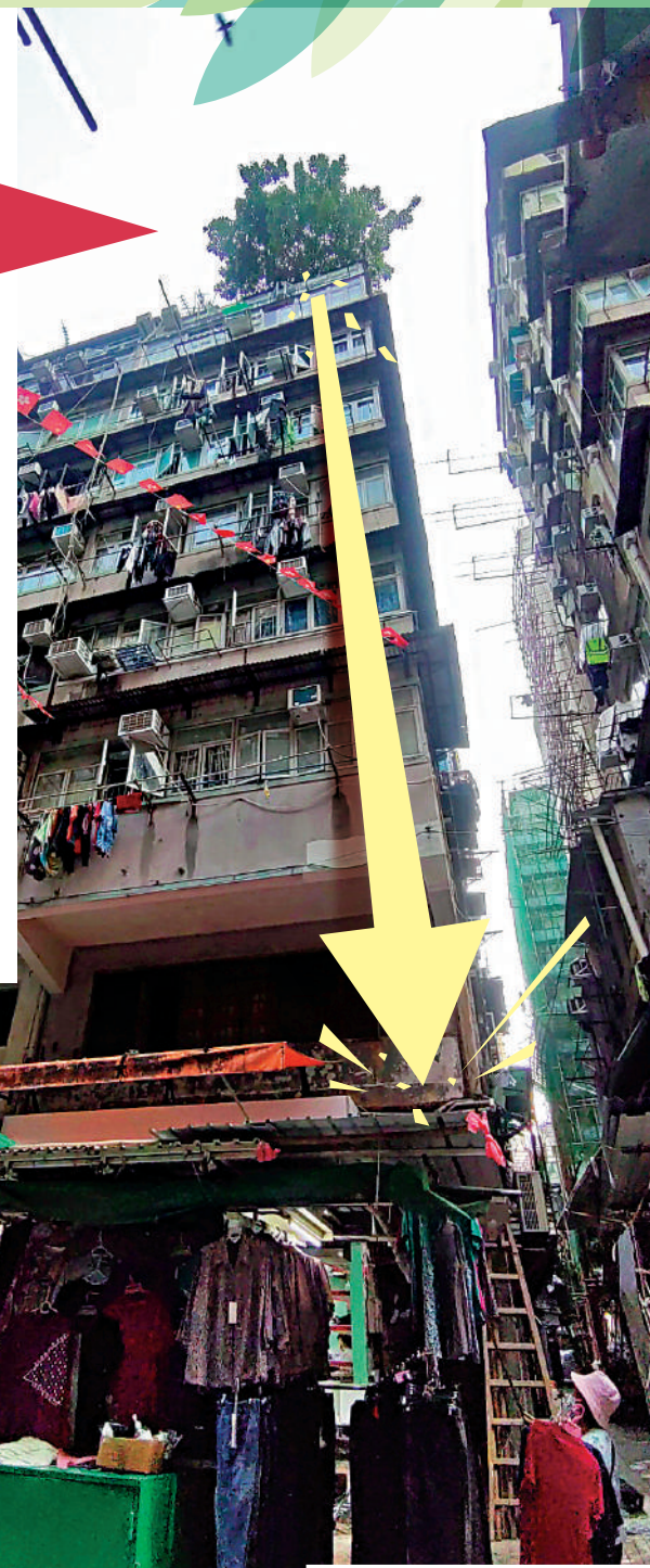
▲天台樹疑扯破外牆令石屎墜街上，壓毀樓下排檔頂部(箭頭示)。
