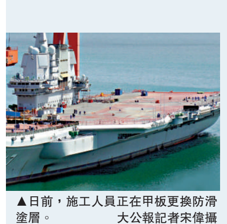
日前，施工人員正在甲板更換防滑塗層。
