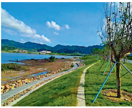
▲大鵬壩光片區周邊山巒環繞、植被蔥鬱。
