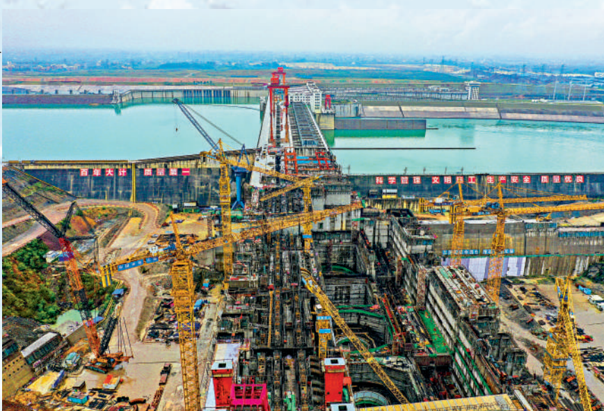
▲西江大藤峽水利樞紐工程。
