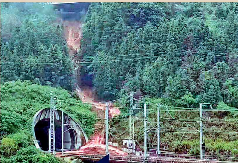
▲貴廣線榕江站進站前的隧道口上方滑坡泥石流侵入軌道。網絡圖片
