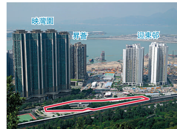
▲東涌牽引配電站上蓋項目(紅色部分)去年11月流標。
