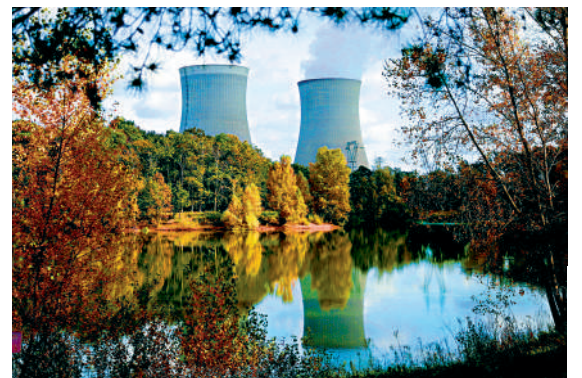
▲法國電力公司核電站冷卻塔上的蒸汽。
