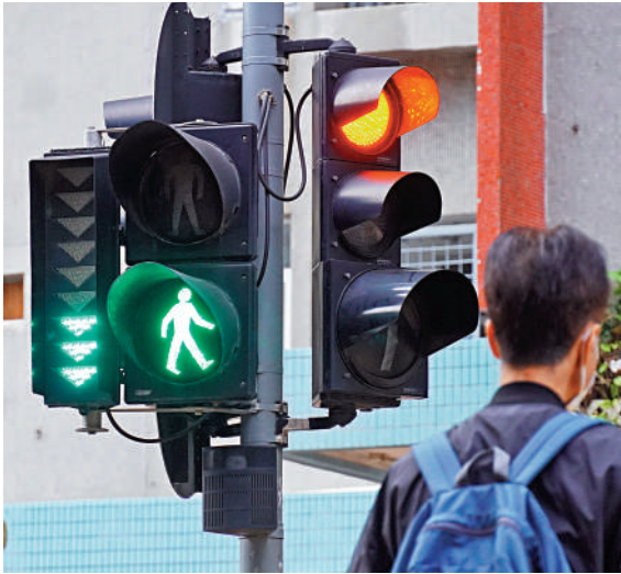
▲實時交通燈號調節系統將會透過安裝在路口的雷達感應器，收集實時交通流量數據，把道路使用者的延誤減至最低。
