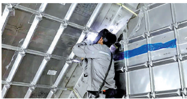
滬東中華的技工正在薄膜圍護系統施工。
