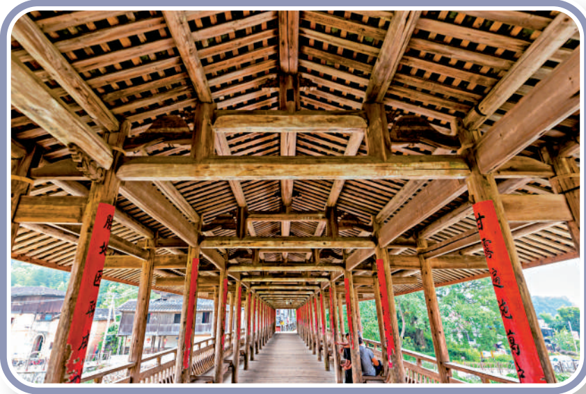
▲萬安橋橋長98.2米、寬4.7米，全橋為木質結構。
