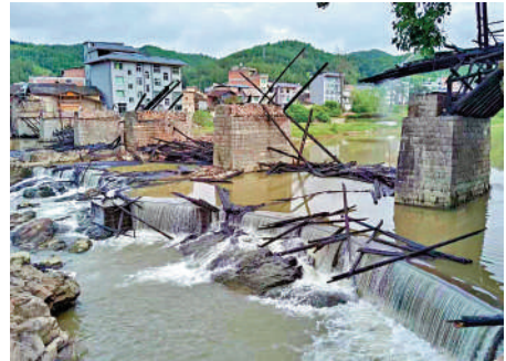
▲失火現場，萬安橋六跨木構建築剩一跨，現場明火已全部撲滅。被燒焦的木材散落遍地。
