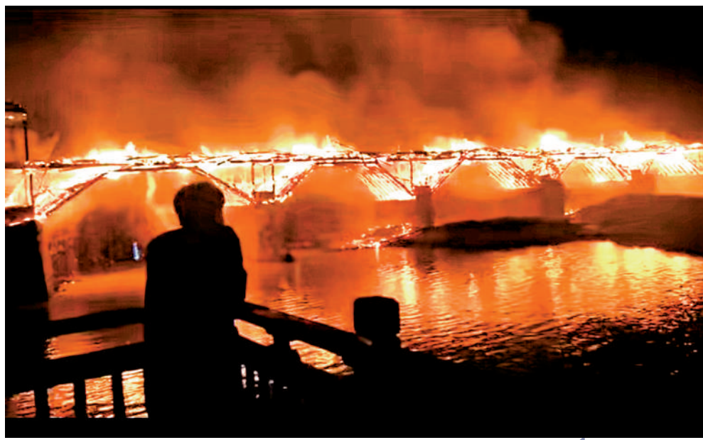
▲8月6日21時許，福建寧德，中國現存最長木拱廊橋——萬安橋失火。
