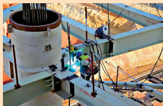
▲ CBD標誌塔上，工人在進行高空焊接。受訪者供圖
