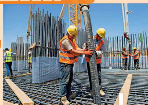
▲ 烈日下，中國建築工人對CBD標誌塔縱深5米的大底板進行澆築。
