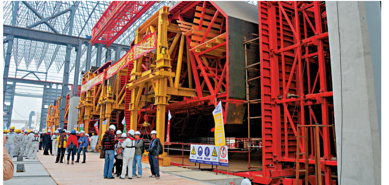
▲錢七虎曾為港珠澳大橋海底隧道工程獻策。圖為港珠澳大橋島隧工程的預製沉管隧道。中新社
