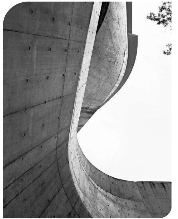
▲赛马會創新樓的曲線混凝土牆。
