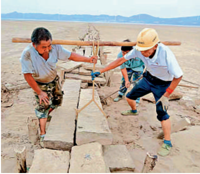
▲工人在修繕千眼橋。 大公報記者王逍攝
