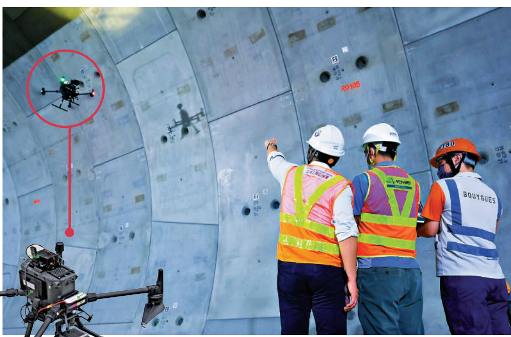
「智能隧道質量檢測系統」應用在T2主幹路及茶果嶺隧道的檢測工作，大幅提高工作效能。
