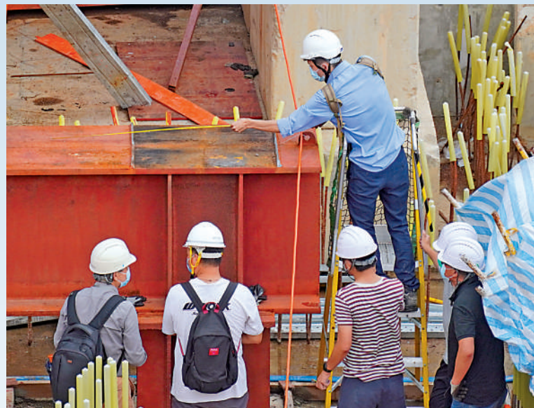
▲事發後，地盤內整支天秤橫向倒塌，其中一支紅色的工字鐵被整個反了過來。
