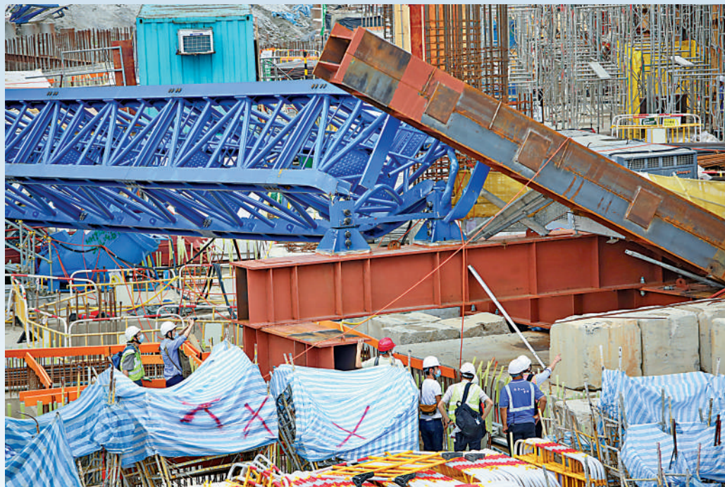
▲事發後，地盤內整支天秤橫向倒塌，其中一支紅色的工字鐵被整個反了過來。
