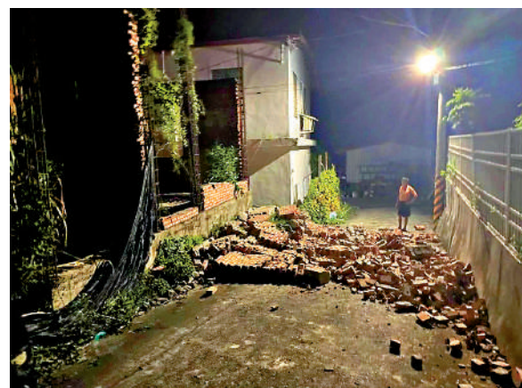
▲台東縣海端鄉山平部落一處紅磚牆因地震倒塌。網絡圖片
