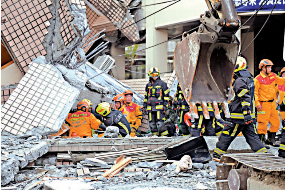
▲台東18日發生6.9級地震。花蓮縣玉里鎮一幢3層樓房倒塌，4名民眾受困，已被全部救出。
