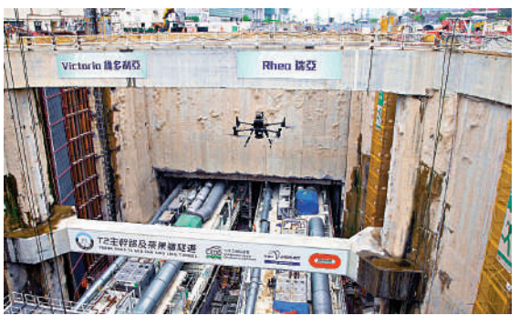
生產力局研發香港首台搭載人工智能技術的隧道施工巡檢航拍機。
