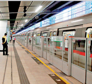
除東鐵綫外，港鐵其他路線的車站已安裝幕門。
