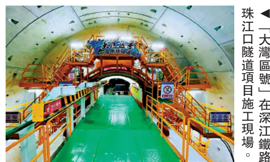
「大灣區號」在深江鐵路珠江口隧道項目施工現場。戰中國之最，為目前中國最大埋深，最高水壓的水下隧道——深江鐵路珠江口隧道項目服務。
