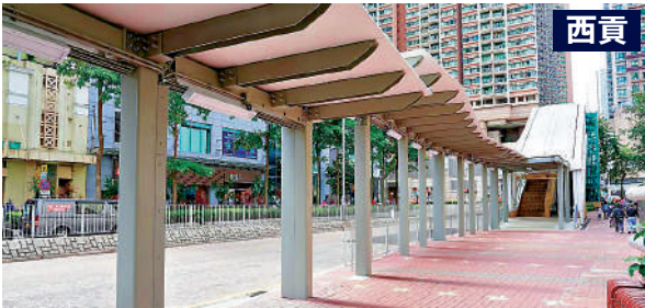
▲部分行人通道加建上蓋，為市民「遮光擋雨」，圖為西貢銀澳路項目已經完成。
