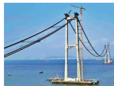
▲深中通道伶仃洋大橋主纜索股完成架設。
