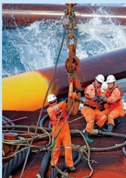
▲「海基一號」安裝過程中，工人在海浪中扶正吊裝鎖具。
