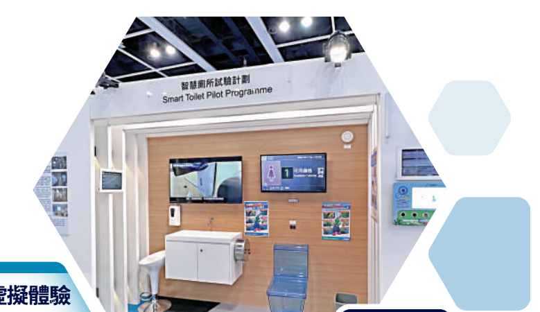
智慧廁所試驗計劃，透過政府物聯網收集相關數據，適時通報公廁使用量、環境參數和消耗品使用情況。
