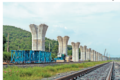
▲這是9月7日在泰國叻叻拍攝的中泰鐵路建設現場。新華社
