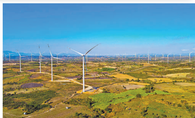
▲8月20日，中國能建總承包建設的越南最大規模陸上風電項目——嘉萊300兆瓦風電項目64台風機全部吊裝完成。
