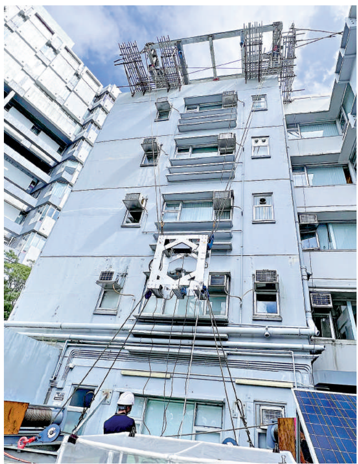
▲多條纜索可控制內置機械臂的平台在空中順暢移動，比一般吊船更穩定。 大公報記者鍾怡攝
