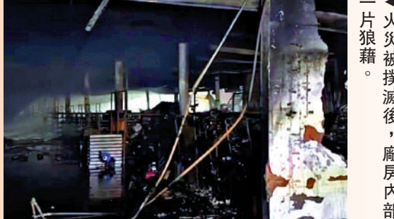
▲火災被撲滅後，廠房內部一片狼藉。
