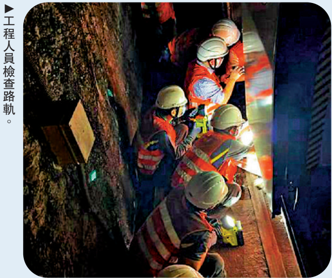
▲工程人員檢查路軌。
