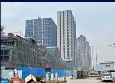
▲已經復工的名門翠園，施工現場實施封閉管理。
