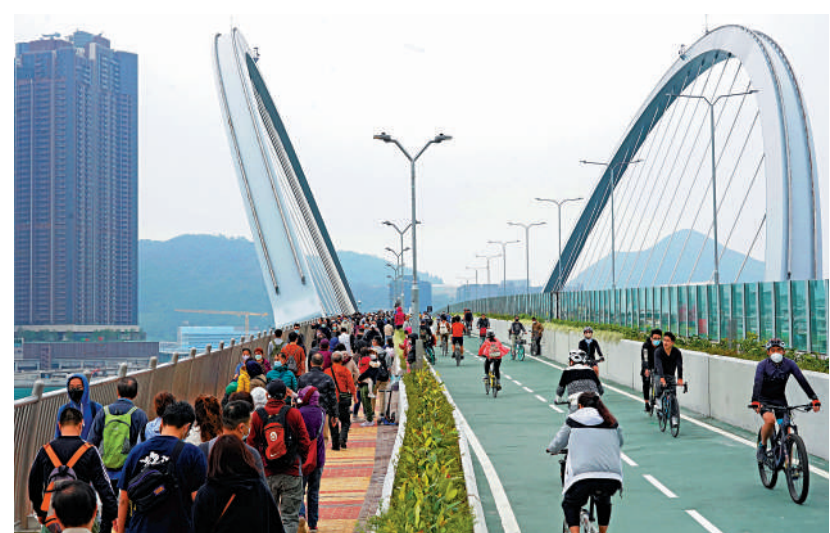
▲將軍澳跨灣大橋的單車徑與行人路昨日便因強風而封閉。圖為大橋本月11日開通情形。
