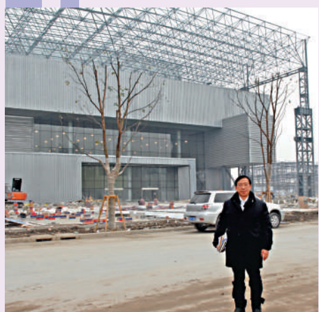
▲上海世博創下了歷史建築保護之最。圖中場館是由原江南造船廠裝焊車間改建。受訪者提供
