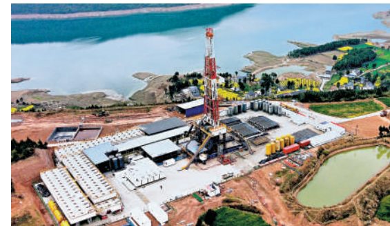
▲元深1井完鑽井深8866米，打破四川盆地直井最深紀錄。 網絡圖片
