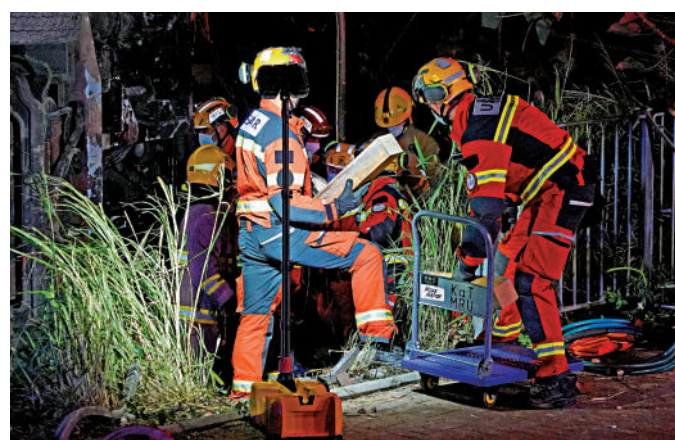
▲消防坍塌搜救專隊人員在現場處理事件。
