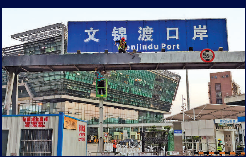
▲在文錦渡口岸，有工人趕工為巨型道路指示牌髹漆翻新。大公報記者黃山攝
