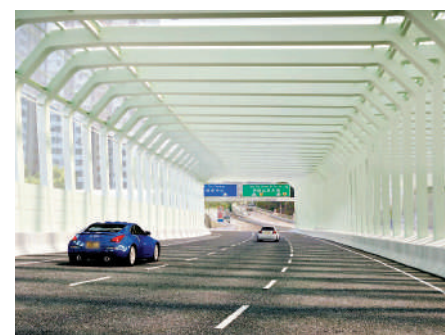
▲新隧道管道啟用後，獅子山隧道公路將裝設隔音屏障等噪音緩解設施。圖為電腦模擬圖。
