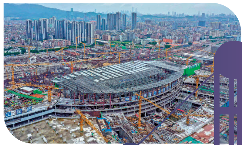
▲正在建設中的廣州白雲火車站，建成後將為「高鐵進市區」騰出空間。 新華社
