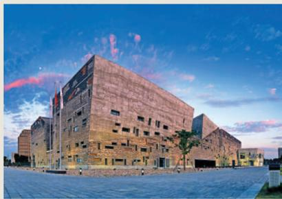
寧波博物館的外觀被塑造成一座山的片斷，外立面由竹條模架混凝土和20種以上回收的舊磚瓦混合砌築的牆體包裹，主體3層、局部5層，主體2層以下集中布局，兩層以上建築開裂、微微傾斜，演變成抽象的山脈，將寧波地域文化特徵、傳統建築元素與現代建築形式和工藝融為一體。從南面看，南立面是一個絕對二維平面，一個山谷斷口中一座尺度超寬的階梯通向原處的第二層「山」。人們從中部一個扁平的，跨度30米的穿洞進入博物館。在建築開裂的上部，隱藏着一片開闊的平台，通過四個形狀不同的裂口，遠望着城市和遠方的稻田與山脈。
